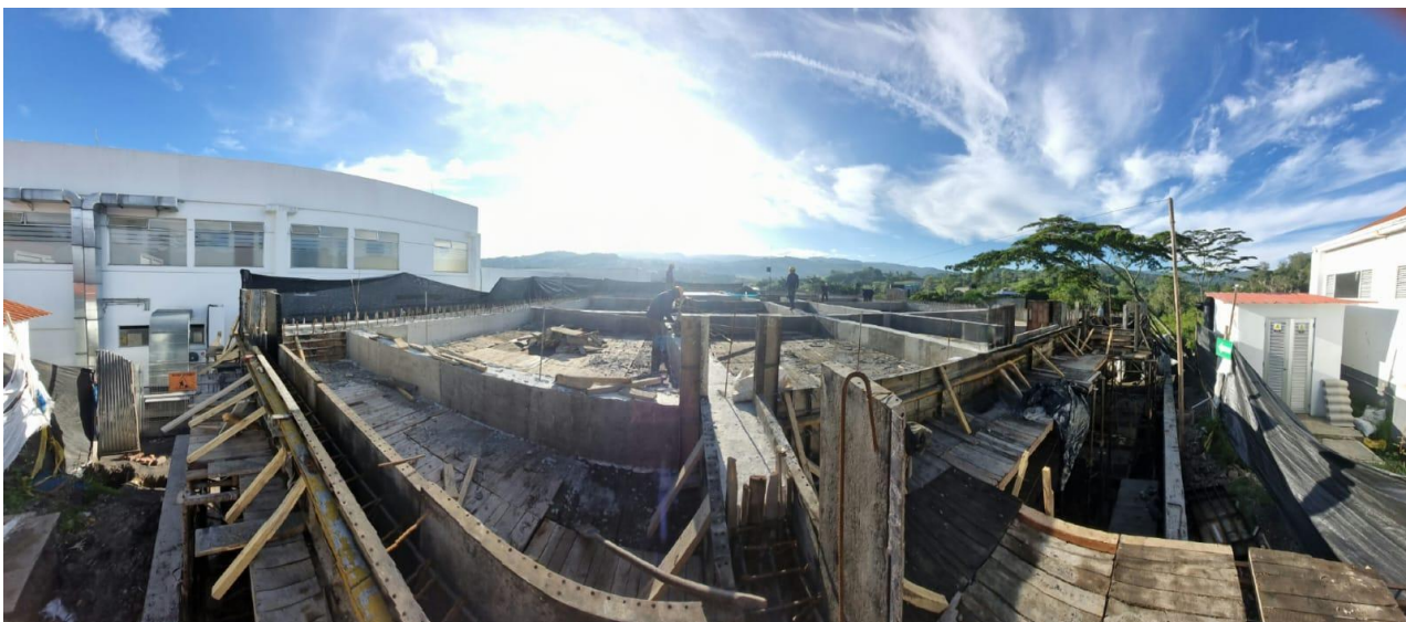
Figura 43.. Levantamiento de muros.
