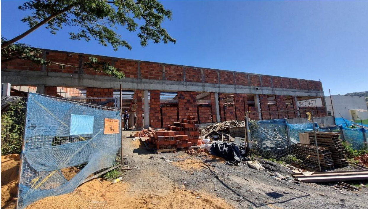
Figura 44. Actividades de Mampostería
