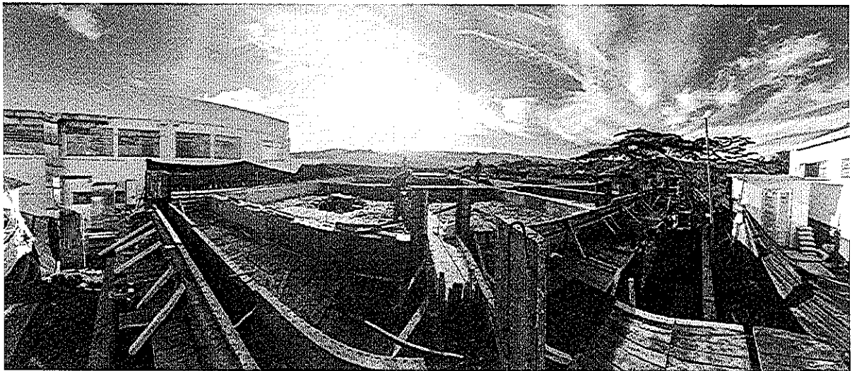
Figura 4.. Levantamiento de muros.
