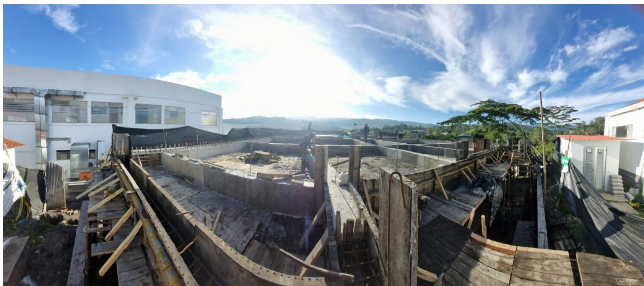
Figura 45. Levantamiento de muros.
