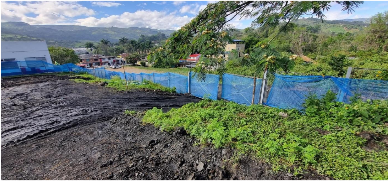
Figura 43. Preparación del terreno
